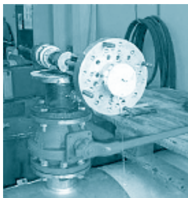
Figure 8-3 Machine de perçage, vanne et morceau du tuyau récupéré
