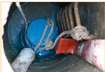
Pour faciliter le terrassement, une pompe et un batardeau permettent de by-passer la Vimière.
