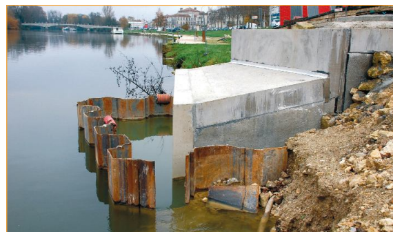
La sortie du nouveau réseau pluvial se situe sous le niveau de la Charente.
