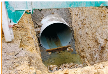
C'est à plusieurs mètres de profondeur que sont posés les tuyaux PRV Ø 2 400 mm de APS Flowtite.
