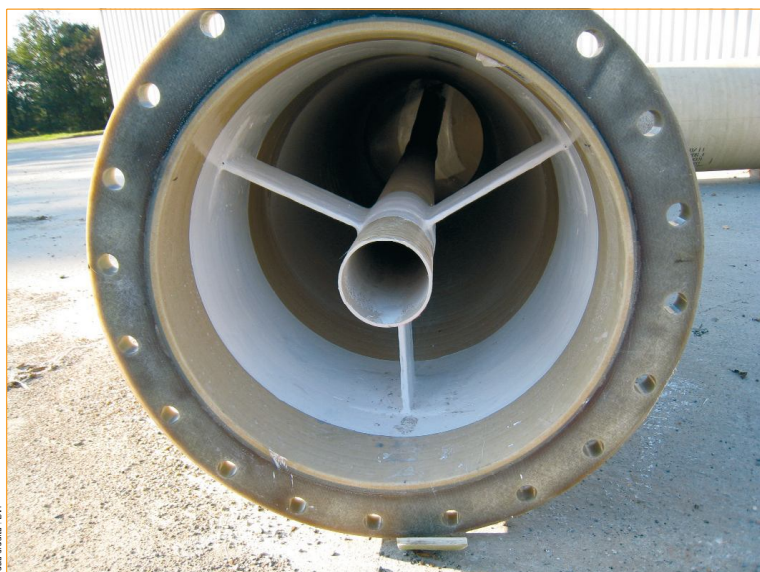
Deux pièces spéciales ont été conçues pour les clarificateurs afin de permettre le passage des systèmes électriques.
