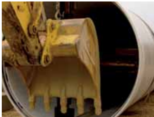
Les méthodes ont élaboré un outil spécial permettant d'emboîter les conduites PVR 3000
