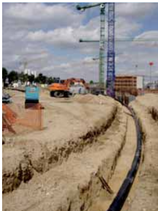
Réseau PEHD 315 sous pression pour le refoulement des boues vers les unités de traitement
